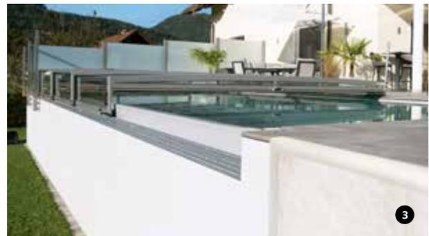
1) Abdeckung einer Römertreppe. 2) Schlitz in der Stirnwand für Handlauf. 3) Niveauunterschied aufgrund einseitiger Überlaufrinne.
